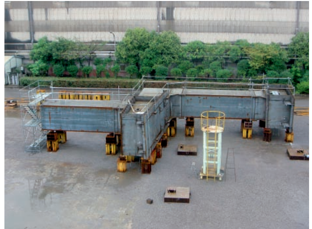
写真-5 Pbd-1 橋脚の全景
