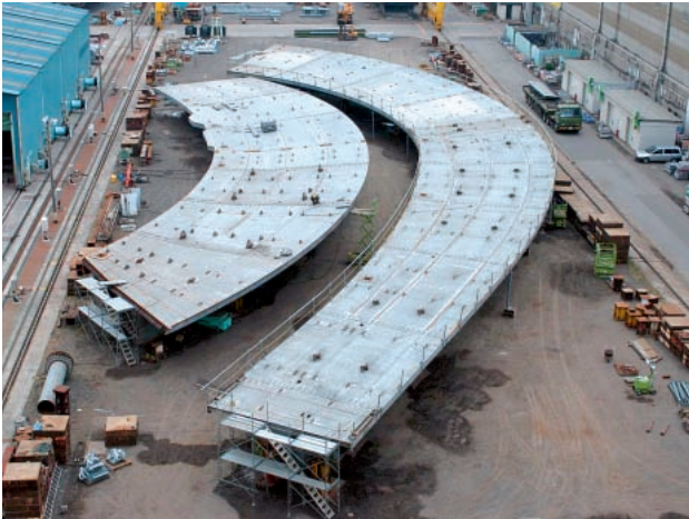
写真-4 B・D連結路主桁の全景 (R=43m・48m)
