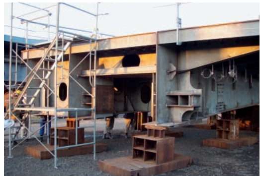
写真-1 D連結路A1側の端支点構造
