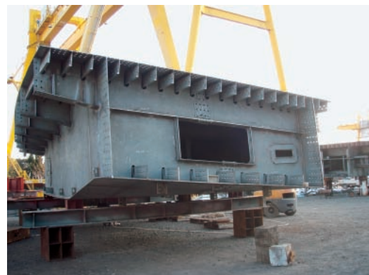
写真-3 既設橋脚回避部の主桁断面
