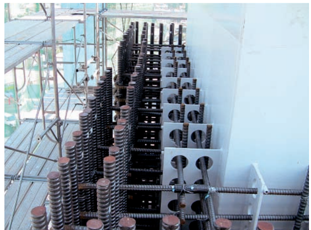
写真-2 複合橋脚結合部の配筋
