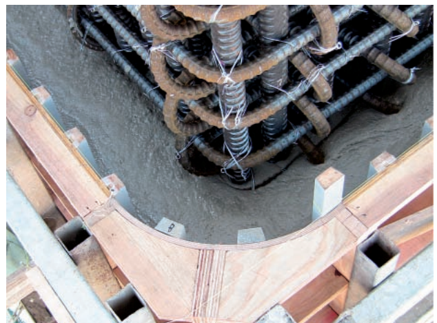
写真-3 複合橋脚結合部の高流動コンクリート打設
