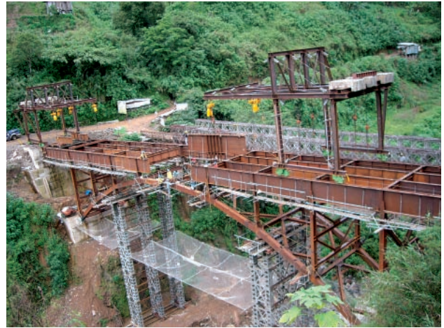
写真-4 閉合ブロック架設状況
