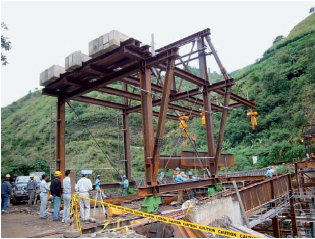
写真-3 ポータルクレーン設置状況
