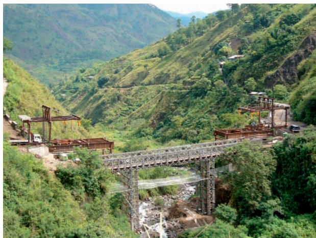
写真-1 架設状況
