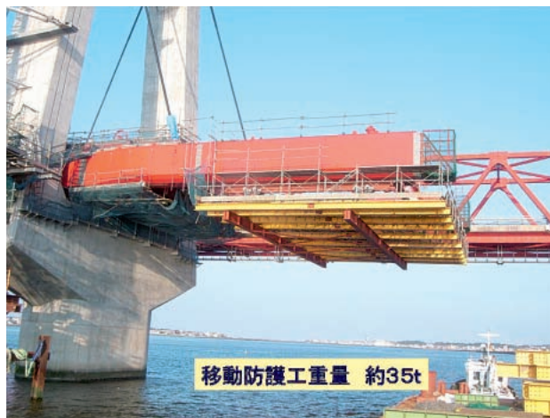
写真-8 移動防護工
