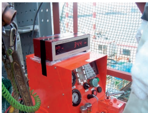
写真-2 ロードセル計測値とジャッキポンプ
