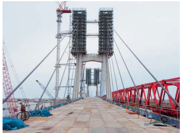
写真-5 橋面覆工設備
