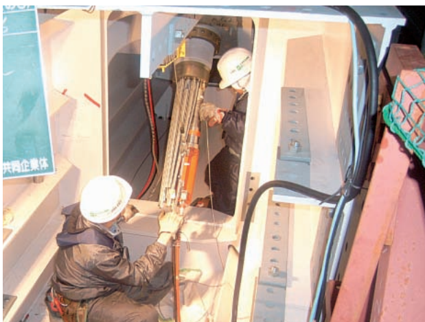
写真-4 斜材ケーブル架設状況（桁側定着部）
