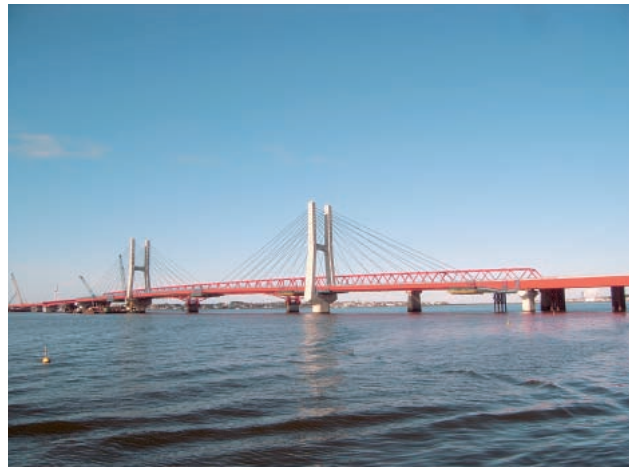
写真一10 銚子大橋斜張橋部全景と現橋トラス
