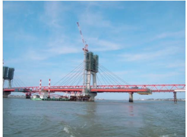
写真-7 バランシング架設状況
