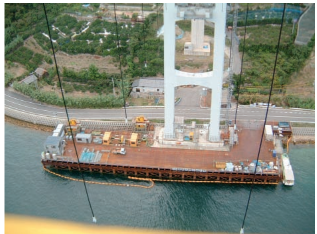
写真－12 栈台上設備配置状況
