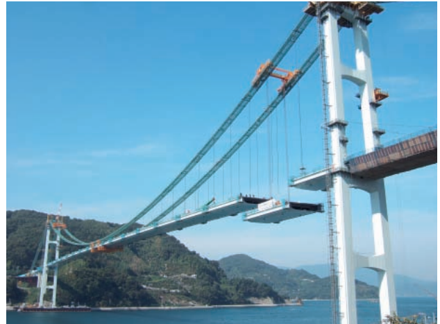
写真－7 閉合ブロックKB-18の架設
