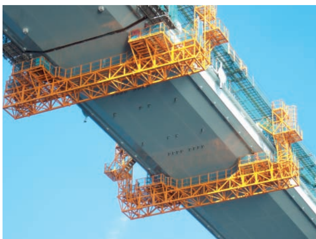
写真-14 移動安全足場設置状況
