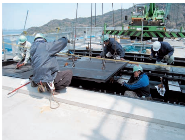
写真－9 伸縮装置据付状況
