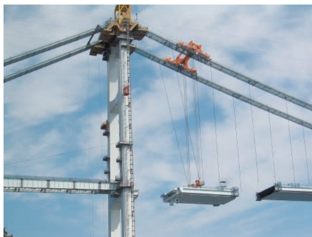
写真-4 スイング架設状況 (1)
