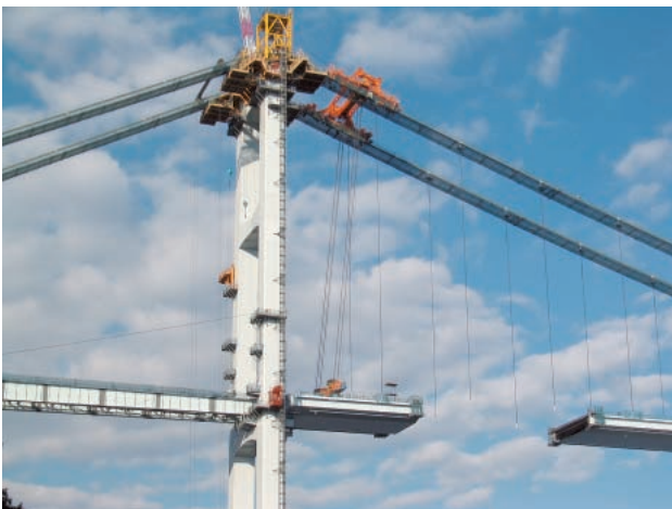
写真－6 スイング架設状況 (3)
