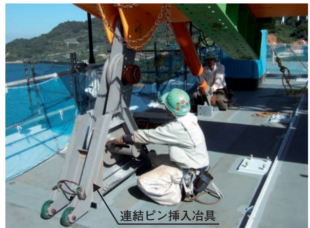
写真-13 補剛桁の2吊点部状況
