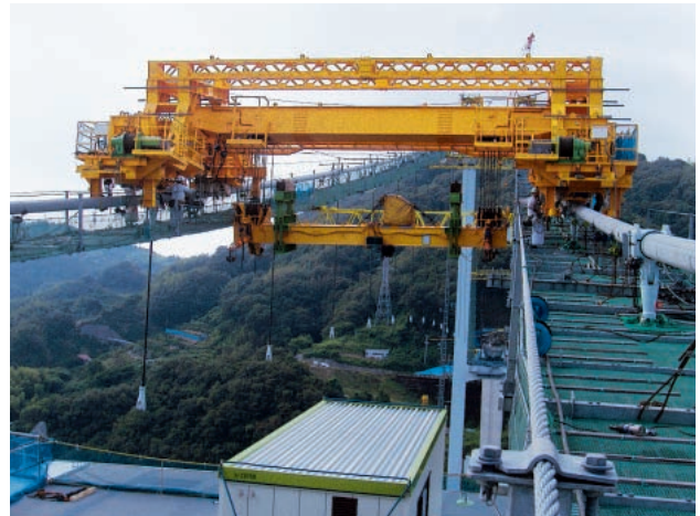
写真－11 リフティングビーム設置状況
