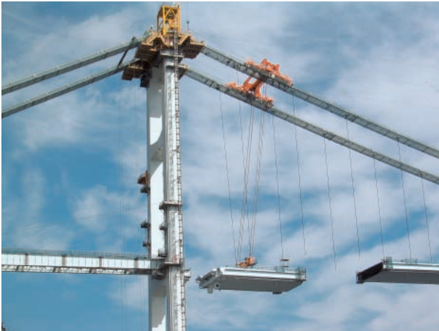
写真－5 スイング架設状況 (2)
