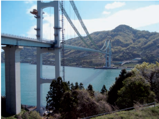
写真-1 竣工時現況
