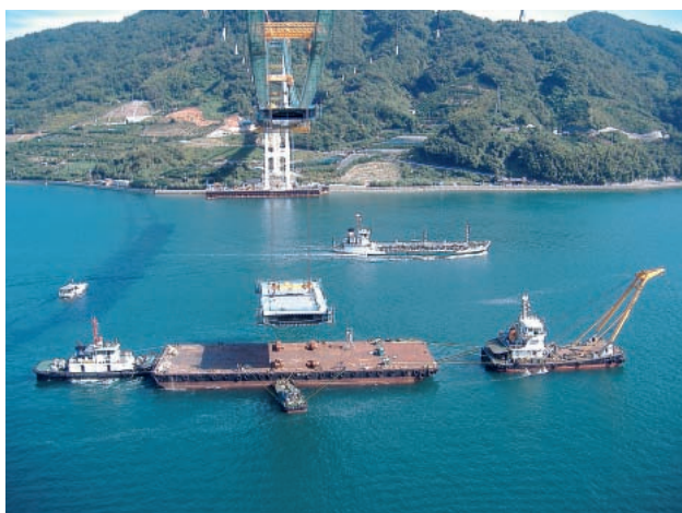
写真-3 直下吊り状況
