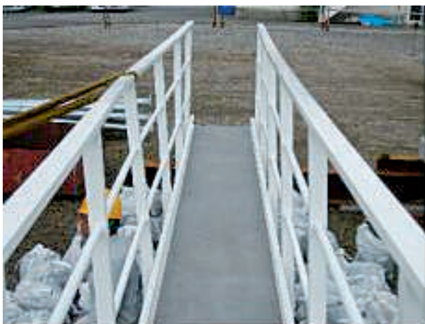
写真－6 手摺りの水平載荷試験
