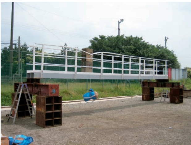
写真－7 落下試験
