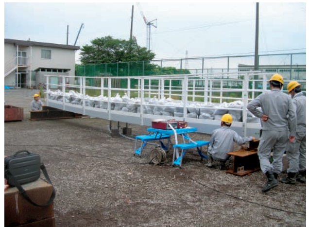
写真-3 鉛直荷重載荷試験
