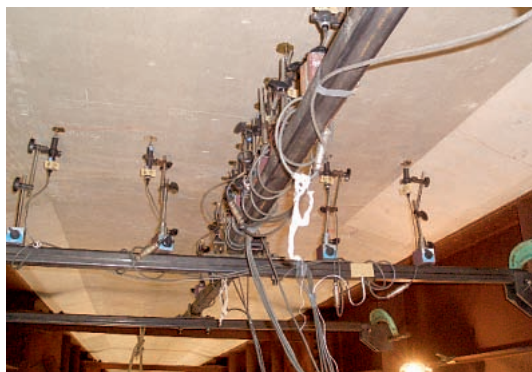
写真-2 変位計取付け状況
