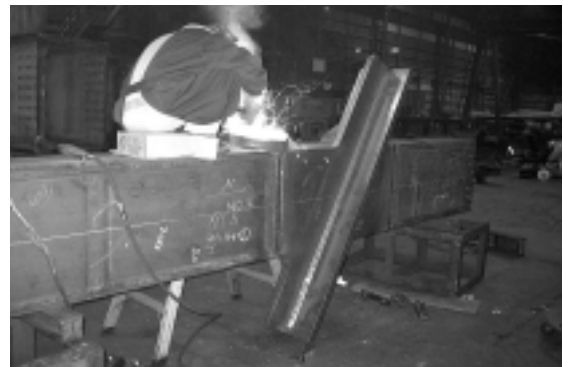
溝形梁とブレース交差部を組立て溶接する 写真-9 溝形梁とブレース交差部のドッキング
