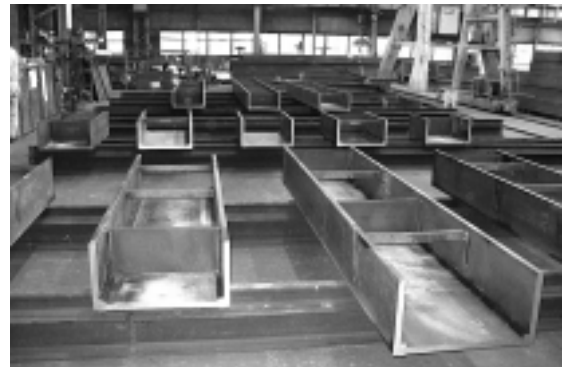
9～10mで製作しバンドソーで切断した状況 写真-7 溝形梁の供取り状況
