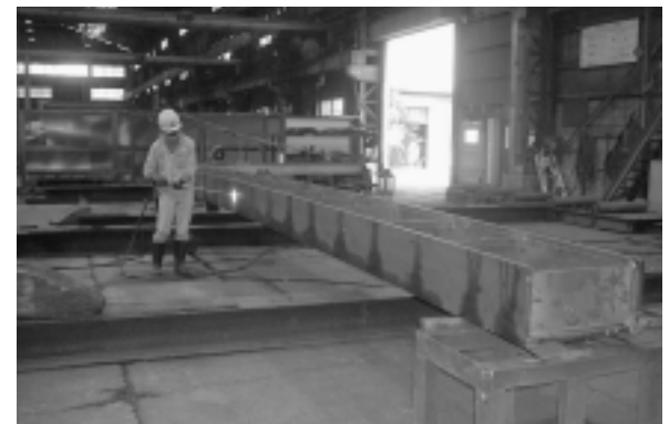
加熱矯正状況 写真-6 加熱矯正作業
