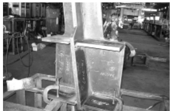
ブレース交差部の製作 写真-8 ブレース交差部
