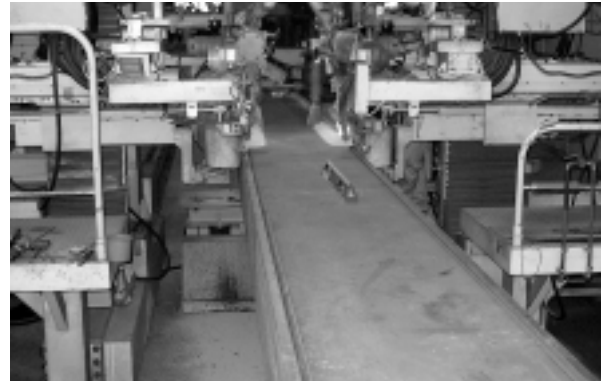
ツイン二電極サブマージ溶接の溶接状況 写真-4 溶接
