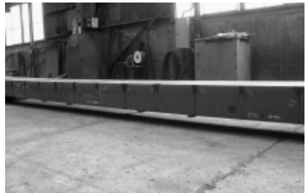
冷却後、中央部で約50mm変形した状況 写真-5 変形状況
