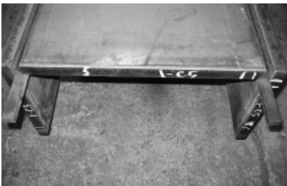
溝形梁を組立てた状況 写真-3 試験体端部状況
