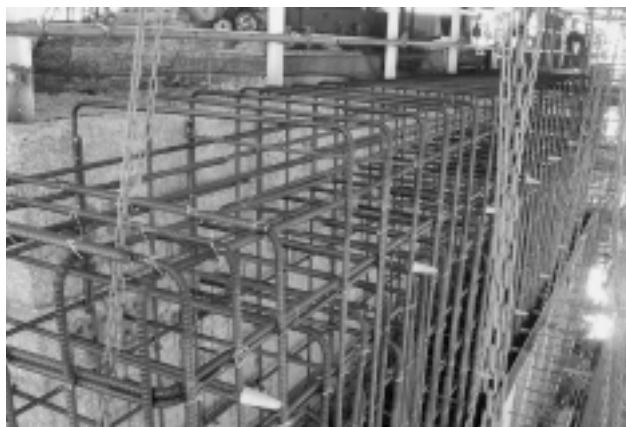
写真-1 緑端拡幅配筋状況
