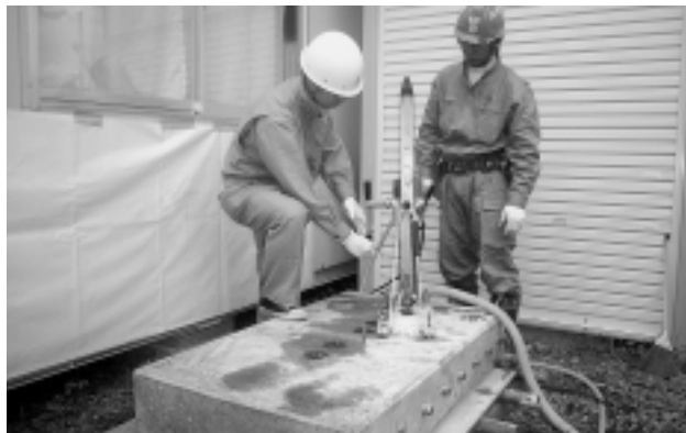
写真-8 施工試験状況
