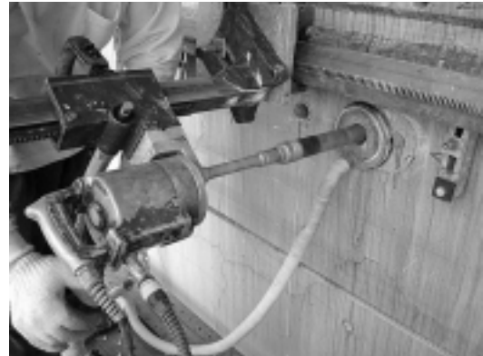
写真－７ 高周波コアドリル施工状況
