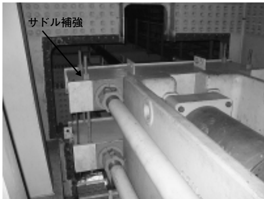
写真-4 サドル補強状況
