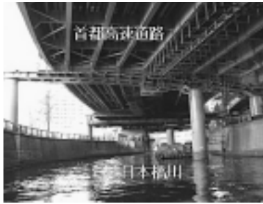
写真-1 現場状況
