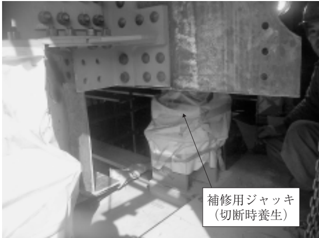
写真-4 主桁切断後の状況
