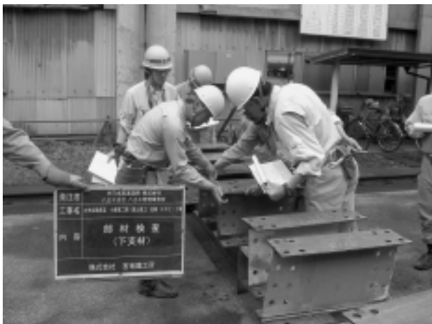
図-15 下支材写真 (部材検査時)
