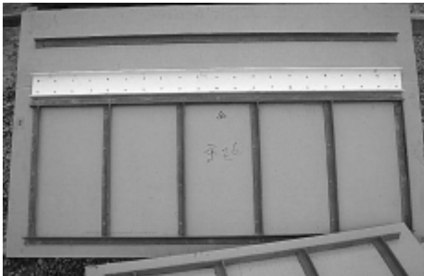
写真-4 主桁側板の補強構造
