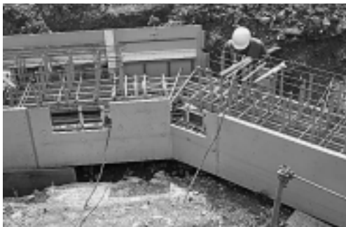
写真-3 杭周り主桁配筋状況 (折れ部)
