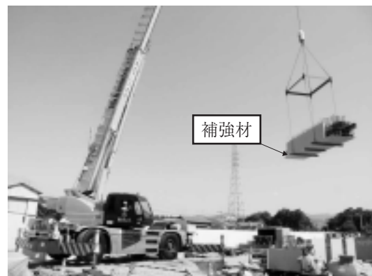
写真-2 主桁パネルの架設状況
