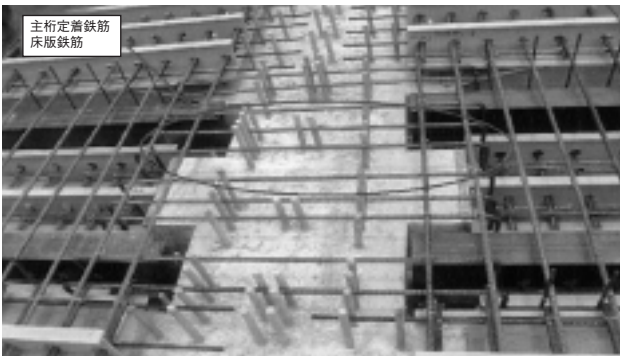
写真-9 床版鉄筋配筋状況
