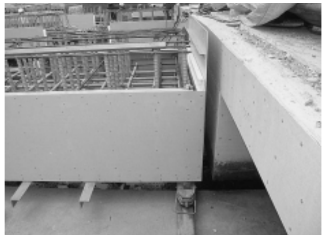
写真-7 張出部仮受け構造(外桁)
