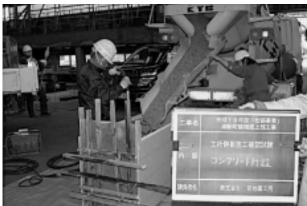
写真-5 施工確認試験状況
