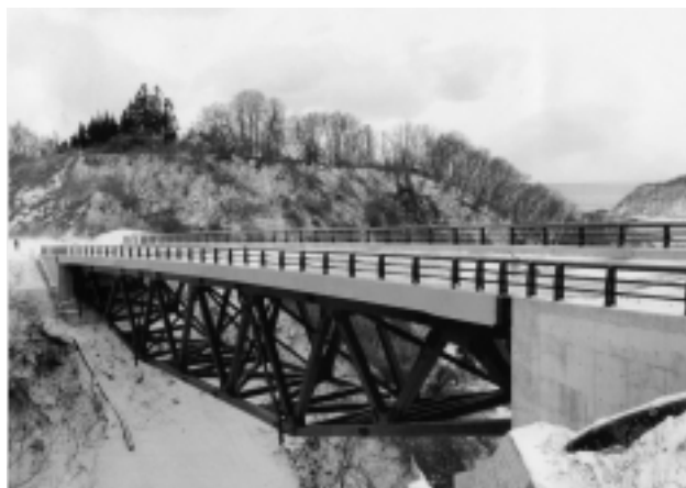
写真-1 竣工写真
