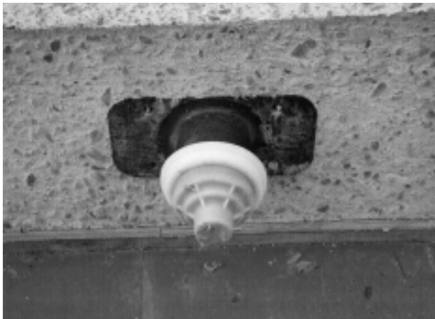
写真-14 PC鋼材切断部の養生
