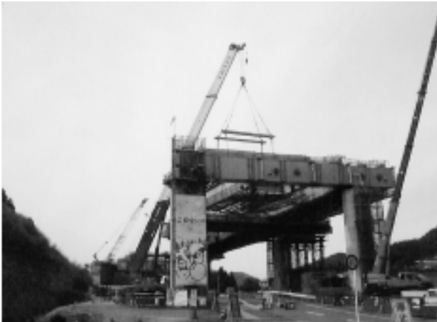
写真-1 県道交差点部鋼桁の大ブロック架設
