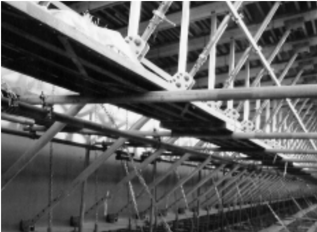
写真-6 床版型枠支保工
