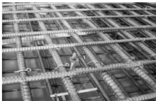
写真－7 鉄筋・PC鋼材の組立状況
