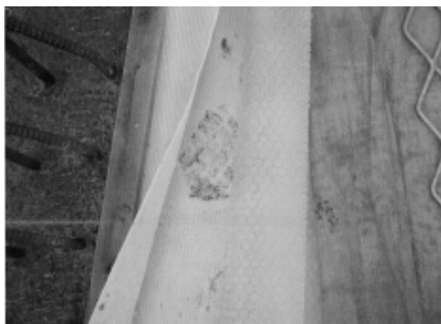
写真-13 コンクリート養生
