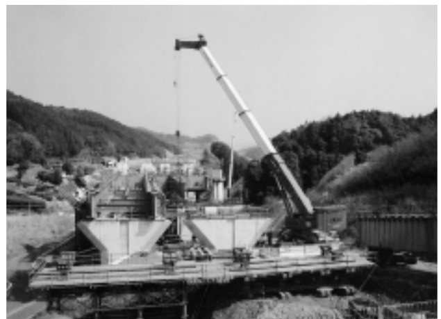
写真-4 A1～P3間の鋼桁架設
