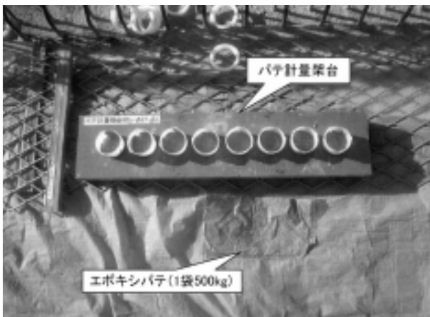
写真-15 エポキシパテの計量状況
