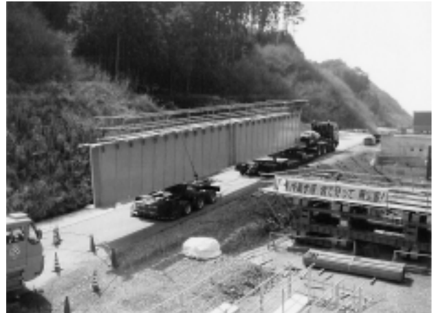
写真-3 鋼桁ブロックの構内運搬
