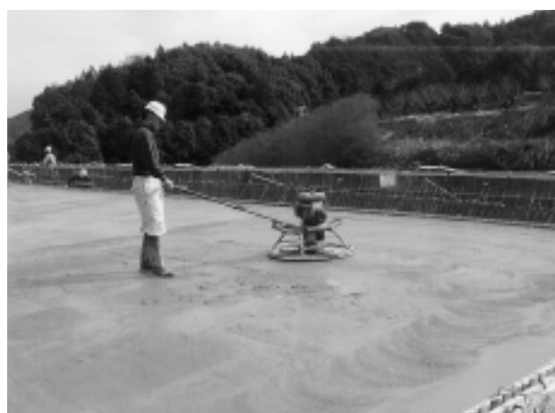
写真-11 トロウエルによる表面仕上げ
