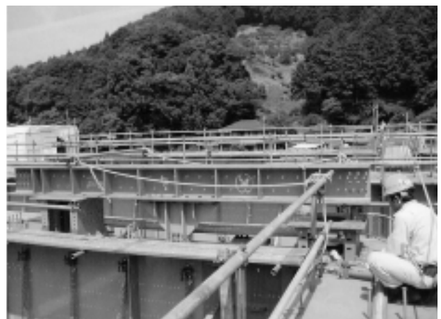
写真-5 セッティングビームによる鋼桁高さ調整
