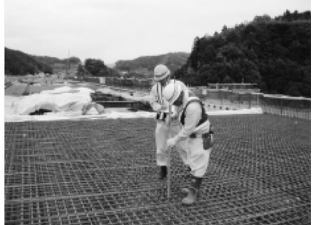
写真-9 PC鋼材設置高さの確認状況
