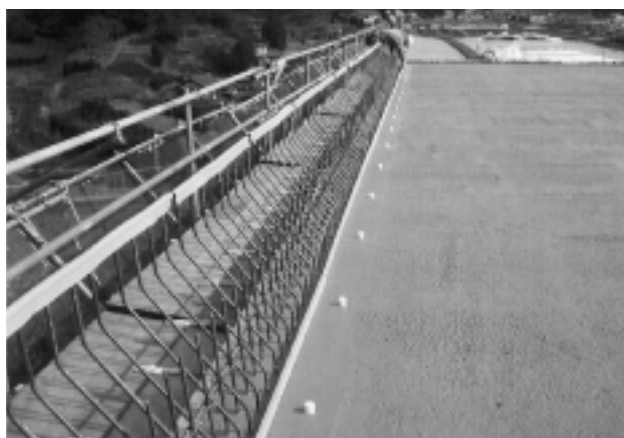
写真-12 止水板の設置状況
