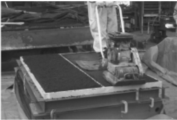
図-4 締め固め状況
