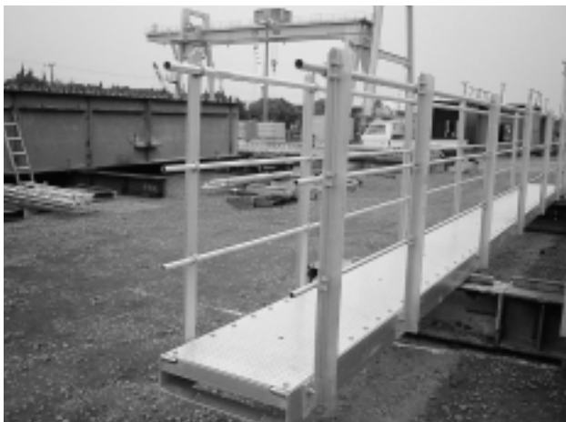
写真一 鋼製検査路の実物写真
