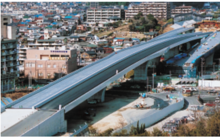
有松高架橋鋼上部工事
