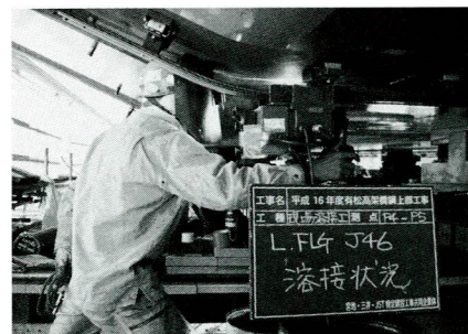
写真-12 斜め上向き自動溶接作業状況
