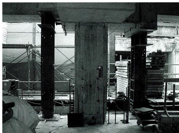
写真-2 仮受支柱設置状況
