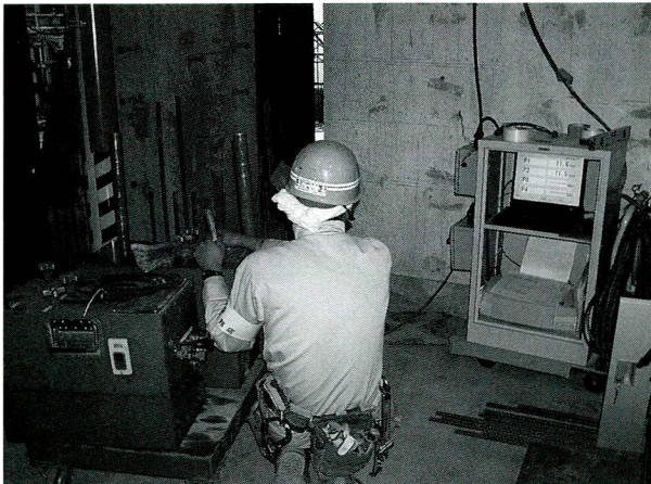
写真-3 プレロード状況
