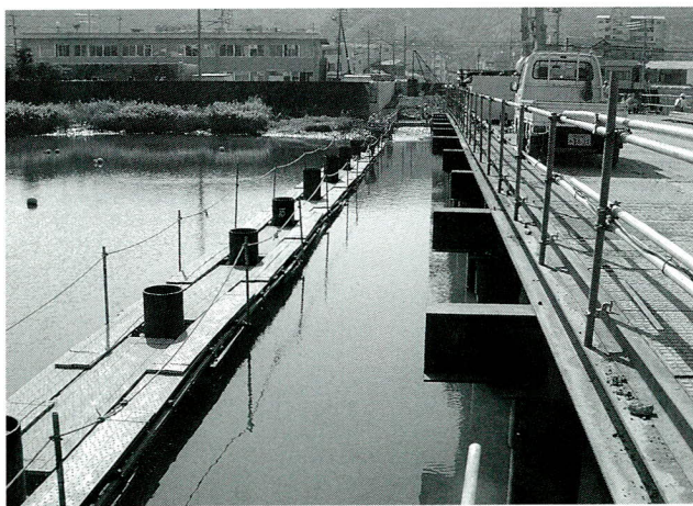
写真-1 栈橋および足場
