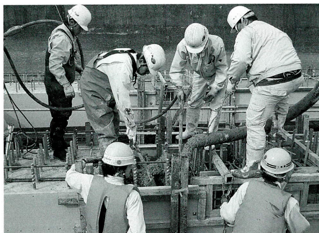
写真-2 主桁部コンクリートの打設
