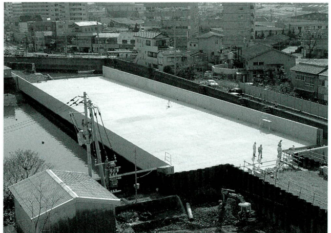
写真一6 完成後の橋梁全景
