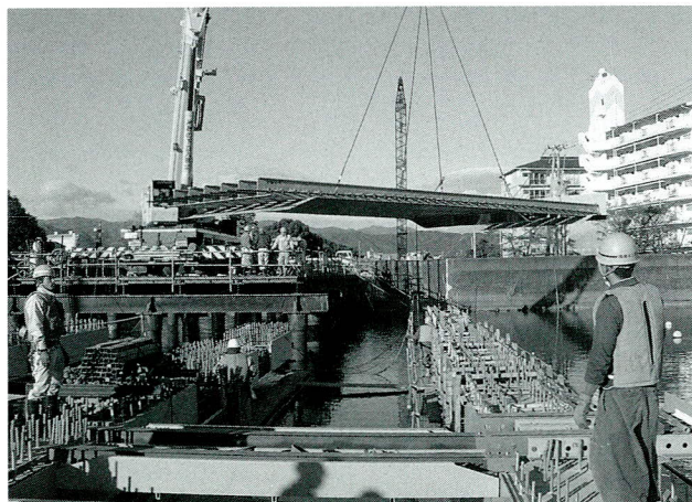
写真-3 FRP床版パネルの架設
