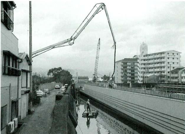
写真一5 壁高欄部コンクリート打設
