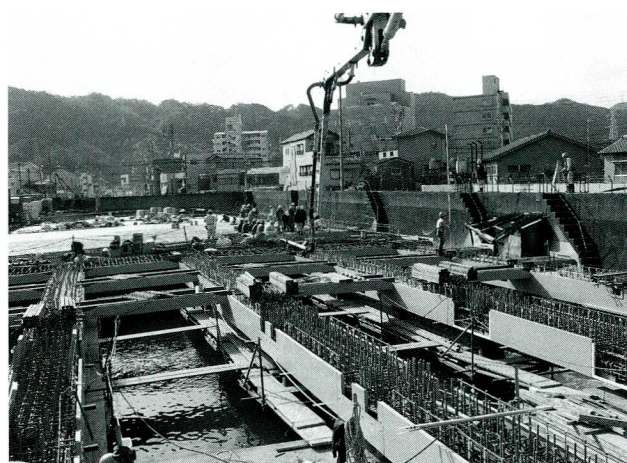
写真-4 床版部コンクリートの打設
