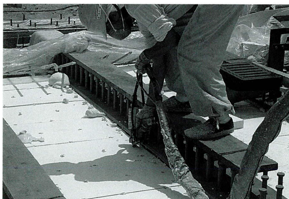
写真-7 ウレタン注入状況
