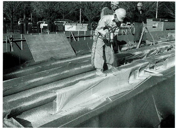
写真-4 ウレタン施工状況
