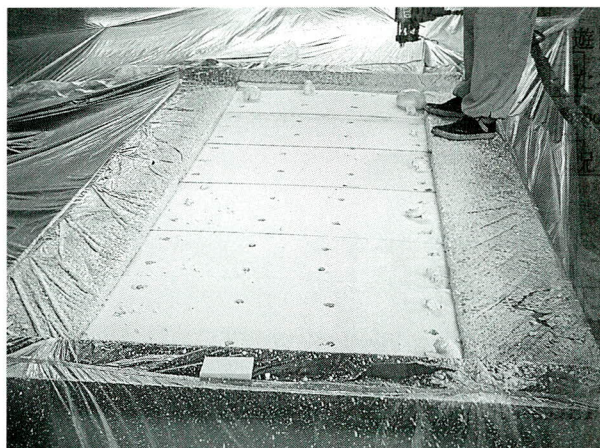
写真-9 ウレタン充填完了状態
