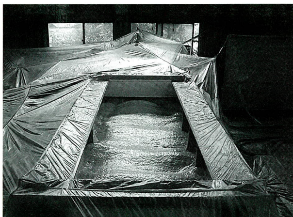
写真-8 先行施工ウレタン充填状況
