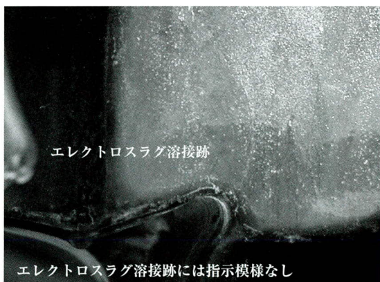
写真-6 エレクトロスラグ溶接跡MT写真
