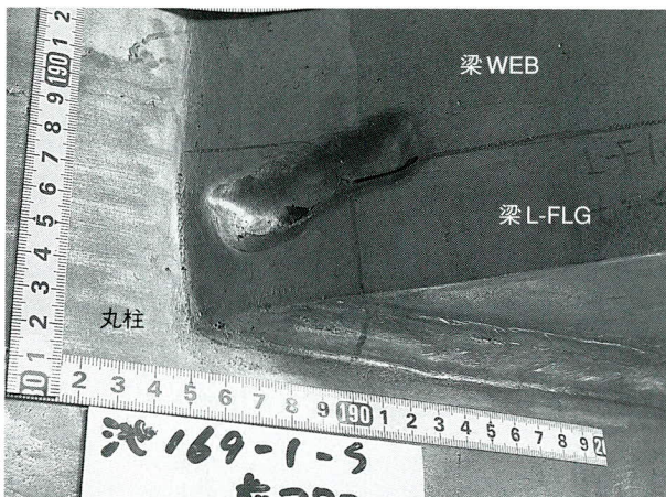
写真-7 step1 き裂範囲の除去
