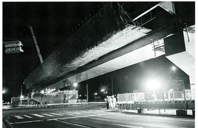
写真-10 一括架設完了
