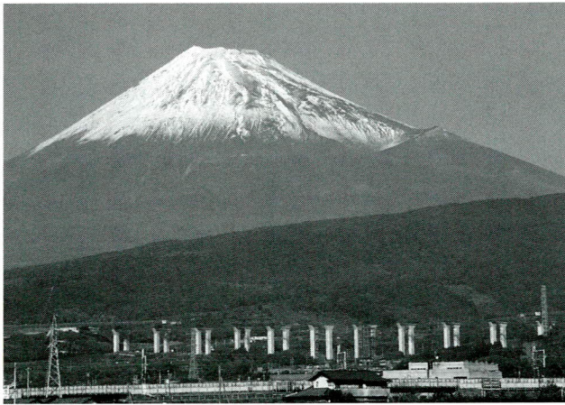
写真-1 現況 (A1橋台側)
