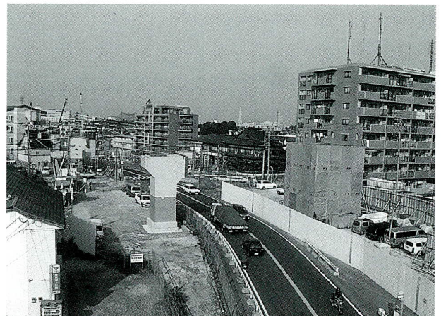
写真-1 片高架橋現場架設状況
