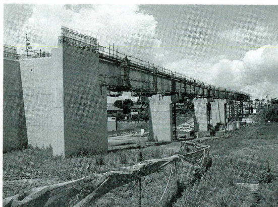
写真-5 架設完了
