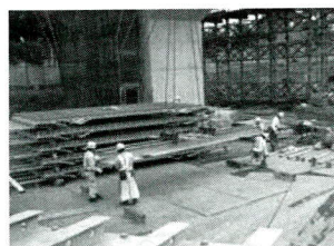
写真-8 張出足場取付
