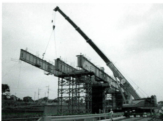
写真-4 主桁架設状況
