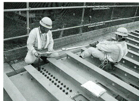
写真-11 節付両ネジ高力ボルト締付け管理
