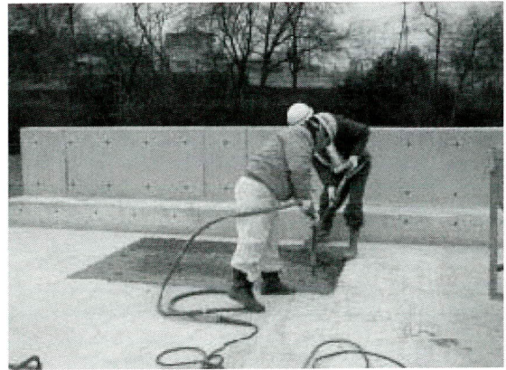
(d) 新コンクリートの締固め
