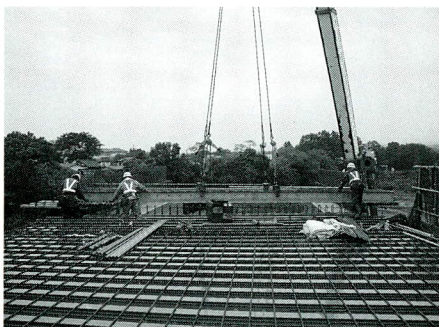
写真-10 合成床版架設状況-2
