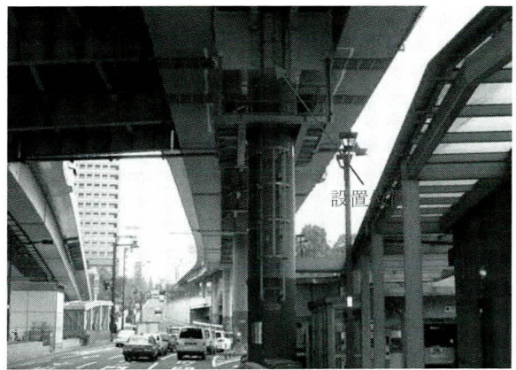
写真-6 鋼製橋脚写真
