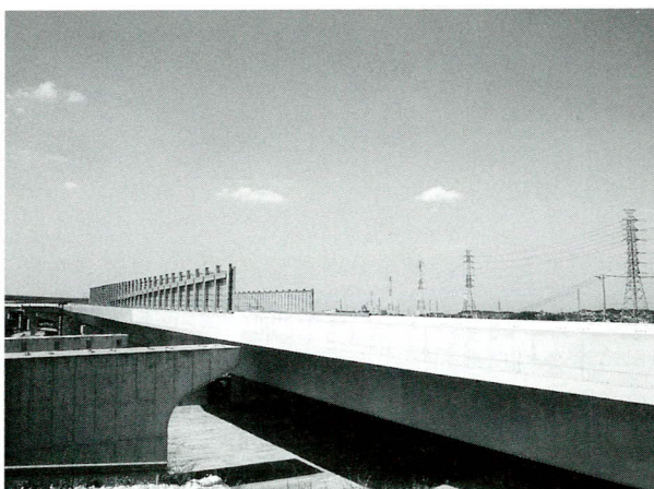
写真-11 完成写真（A1 橋台上より P4 を望む）
