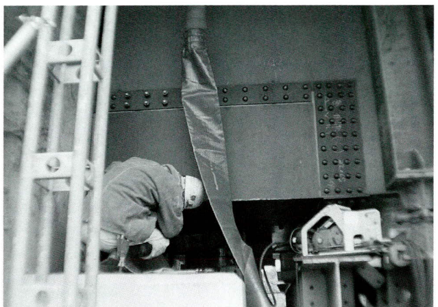
写真-7 部材取付状況
