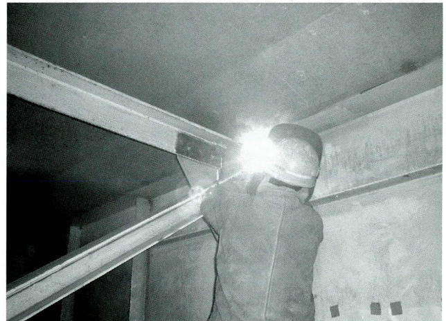
写真-17 ガセットプレート溶接
