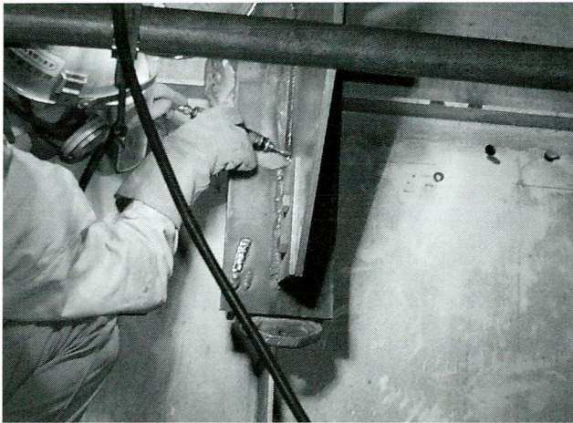
写真-4 グラインダー仕上げ状況
