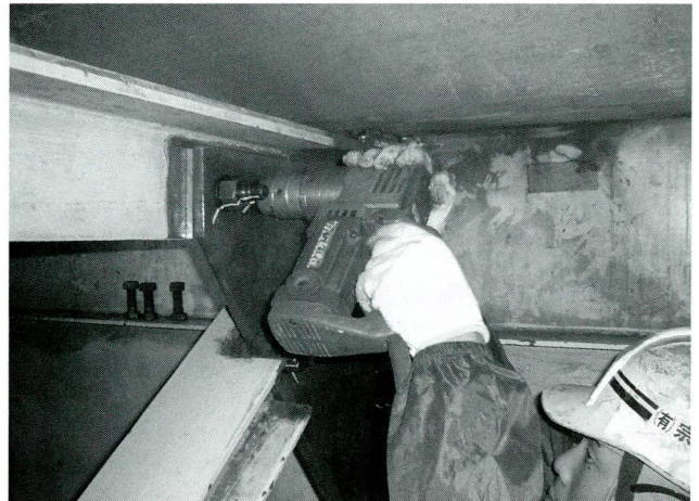
写真-18 高力ボルト本締め
