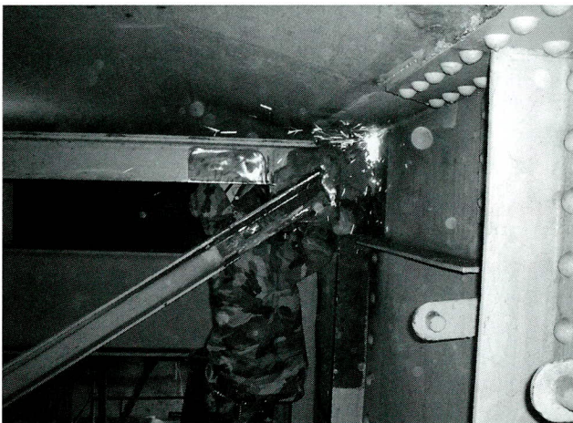
写真-15 既設部材切断状況
