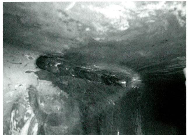
写真-13 ガウジング完了
