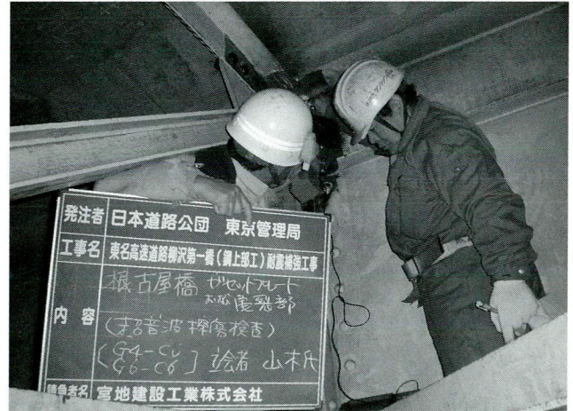
写真-22 超音波探傷試験
