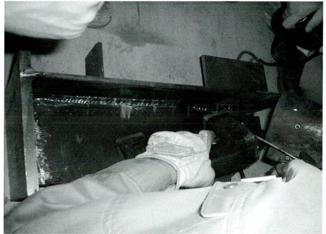
写真-7 磁粉探傷試験状況
