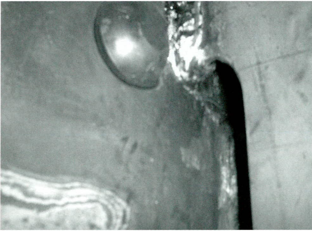
写真-20 止端部仕上げ
