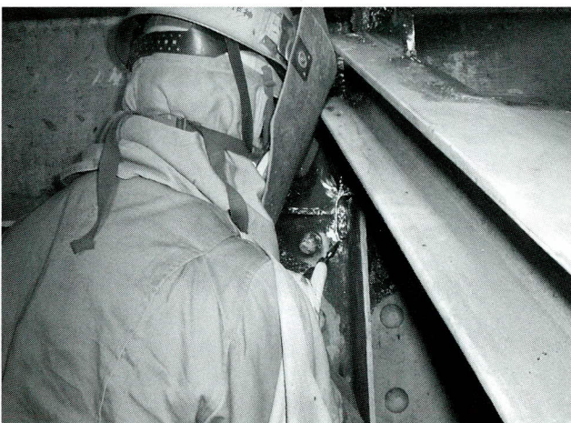
写真-16 切断部仕上げ状況
