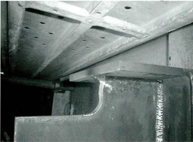
写真-5 溶接完了
