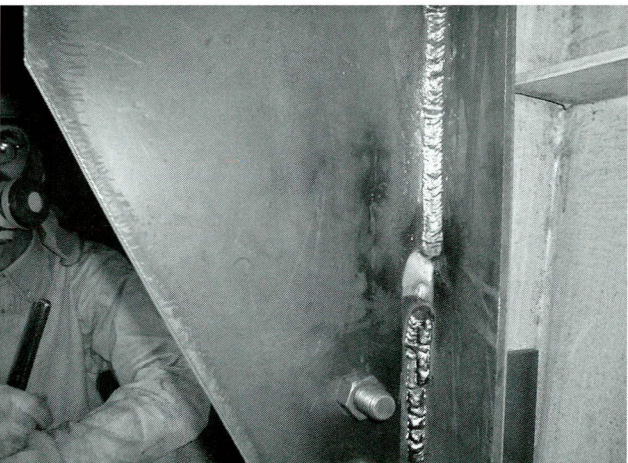
写真-6 溶接完了
