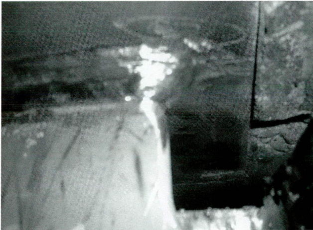
写真-19 止端部仕上げ
