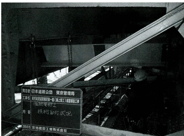
写真-9 横桁取付状況
