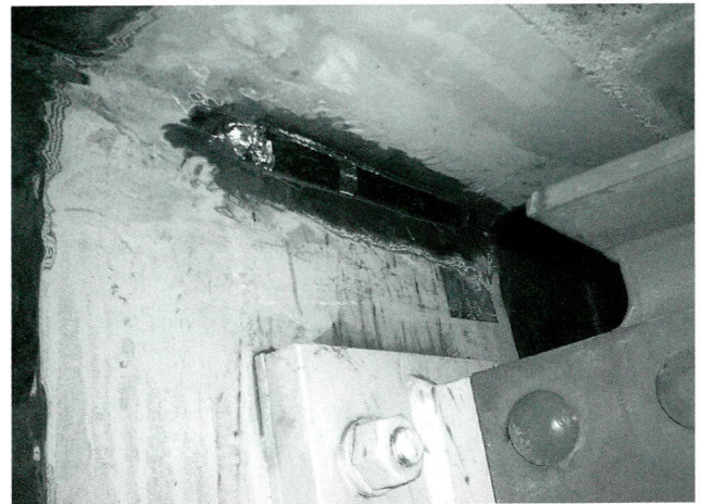
写真-14 亀裂補修完了
