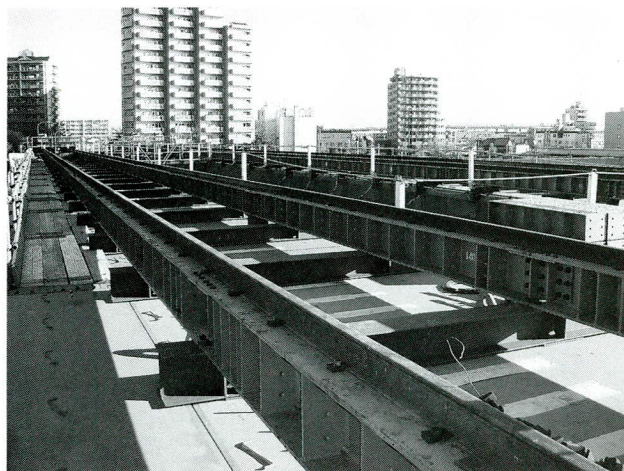
写真一五 桁引き出し軌条設置状況
