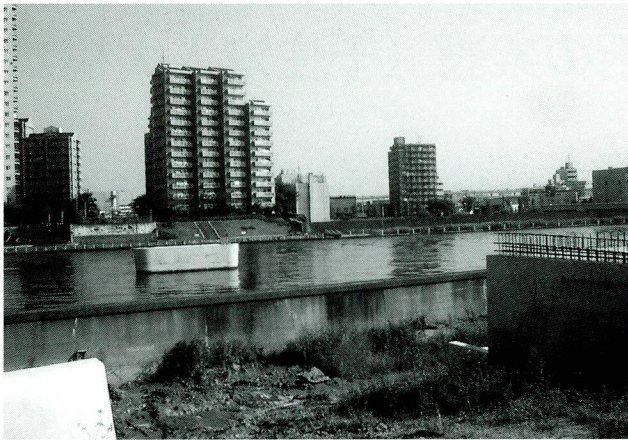
写真-1 着手前状況
