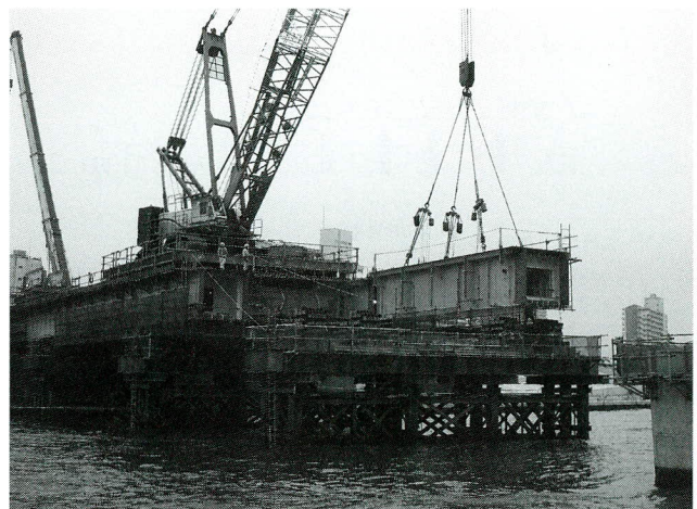
写真一三 架設状況
