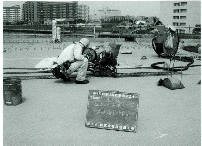
写真-15 鋼床版溶接状況
