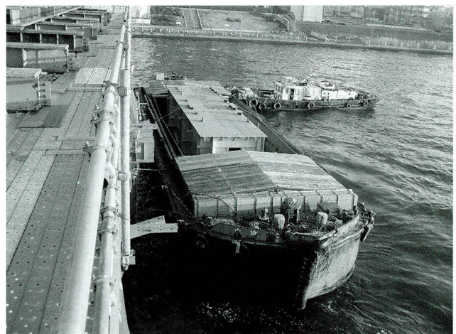
写真一四 海上運搬、現地搬入状況
