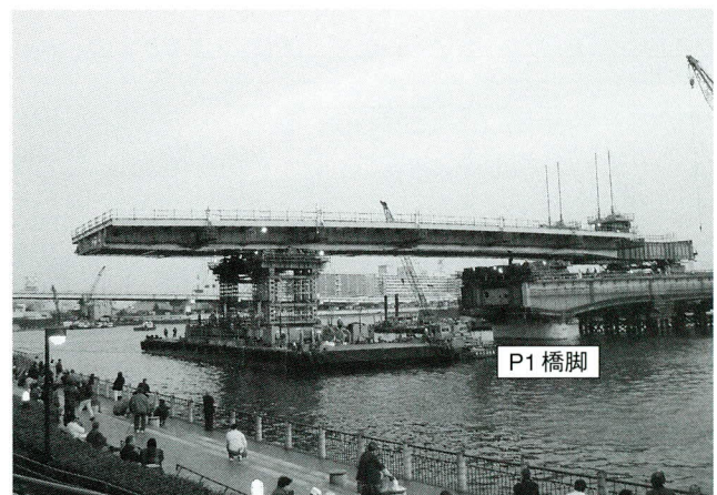
写真-9 台船引き出し作業中 (2)
