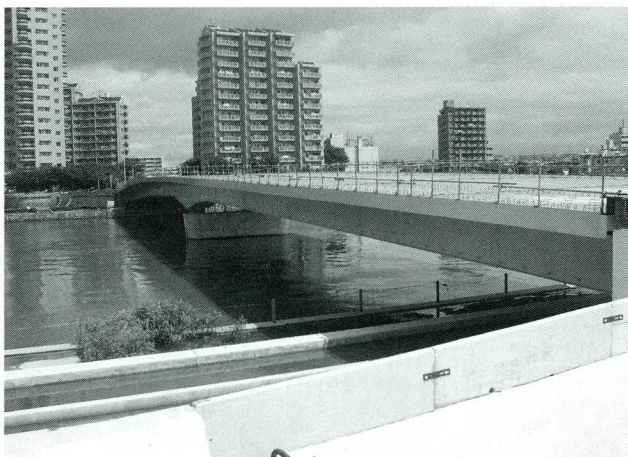
写真-2 架設完了状況
