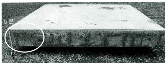
写真-4 P21切断面
