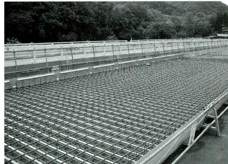
④上側鉄筋の配筋
