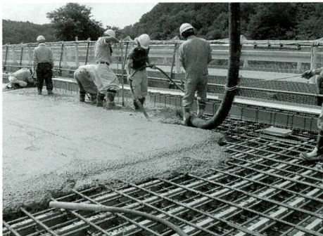
⑤コンクリート打設
