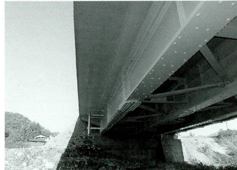
⑥完成（床版下面）
