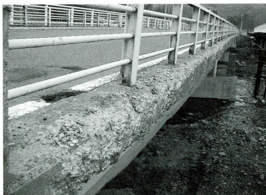
写真-1 工事前の状況
