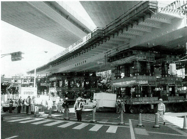
写真-5 架設状況 (STEP-2)
