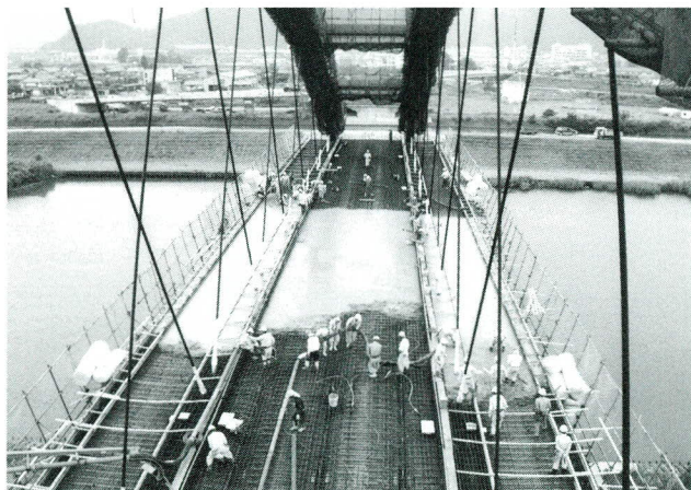
写真-2 コンクリート打設状況
