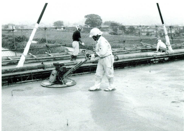
写真-3 トロウエルによる仕上げ
