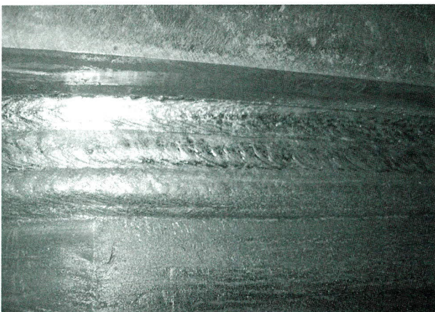
写真-10 NBFW 法溶接外観
