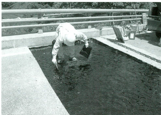
写真-7 加熱型塗膜防水処理
