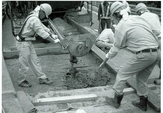
写真-13 コンクリート打設状況
