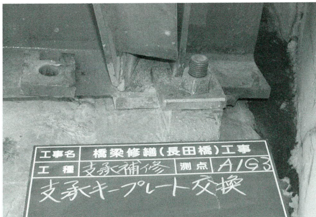
写真-4 支承キーププレート交換
