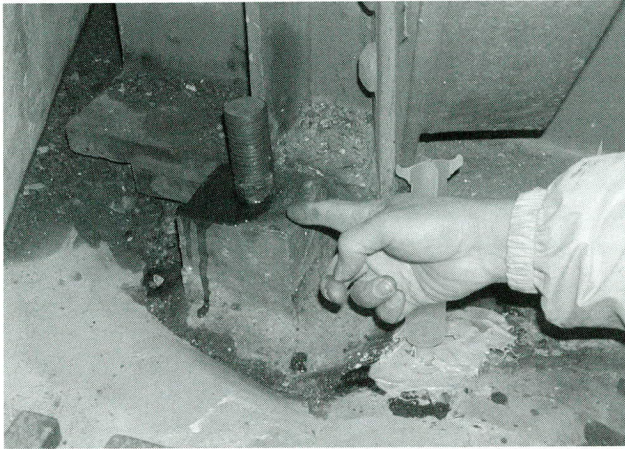
写真-3 樹脂充填確認
