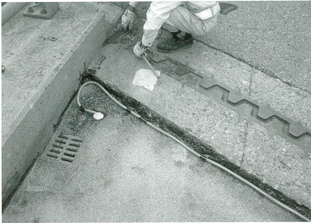
写真-8 導水管敷設
