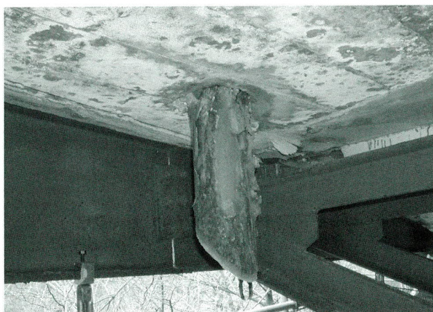
写真-5 既設排水管
