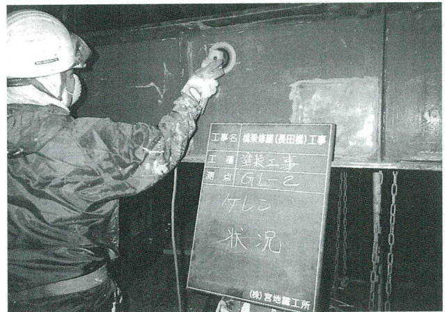
写真-16 ケレン状況・膜厚測定点
