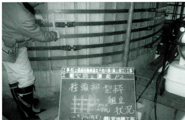
写真-2 木製型枠バンド施工状況
