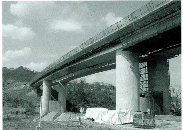
写真-31 足場組立完了
