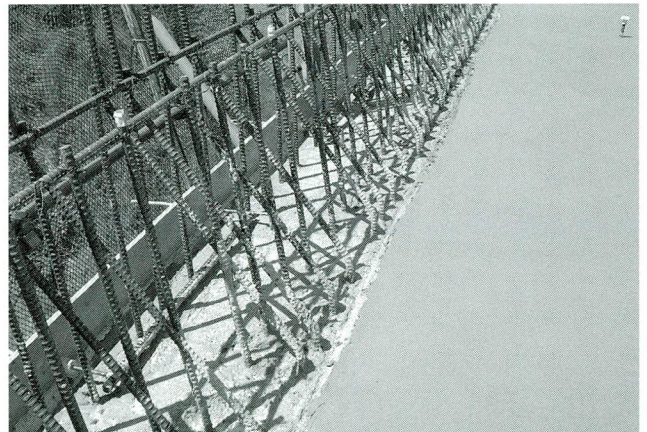
写真-45 壁高欄打継ぎ目遅延材散布完了
