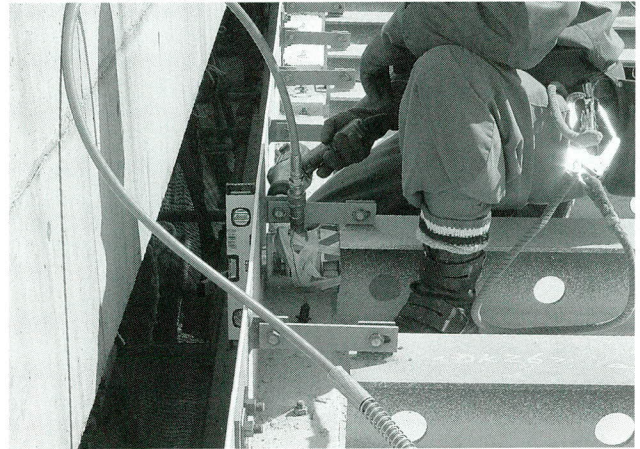
写真一36 側板通り調整状況
