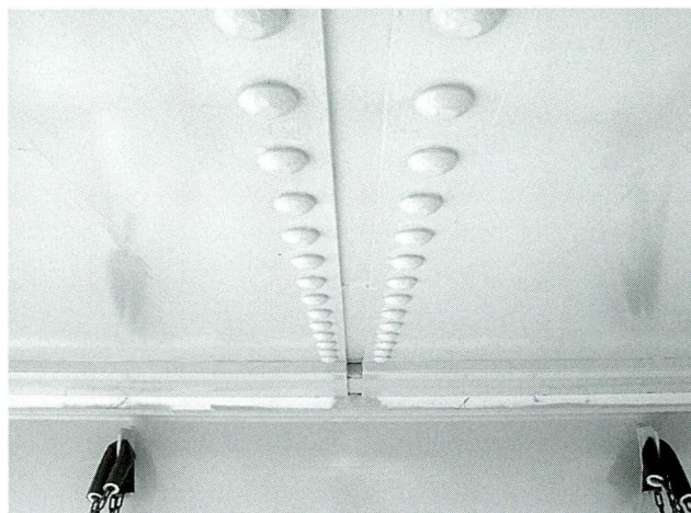
写真-38 調整パネル部外面塗装完了
