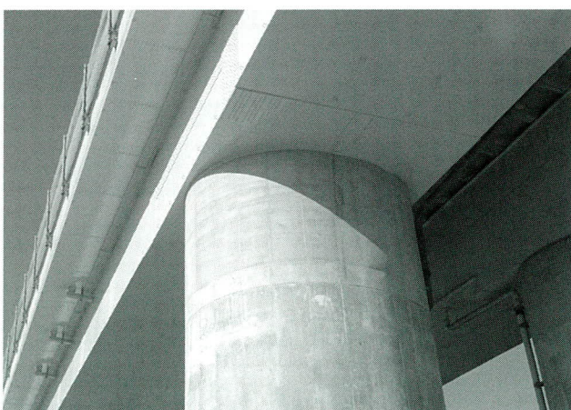
写真一 11 高流動コンクリート打込み完了
