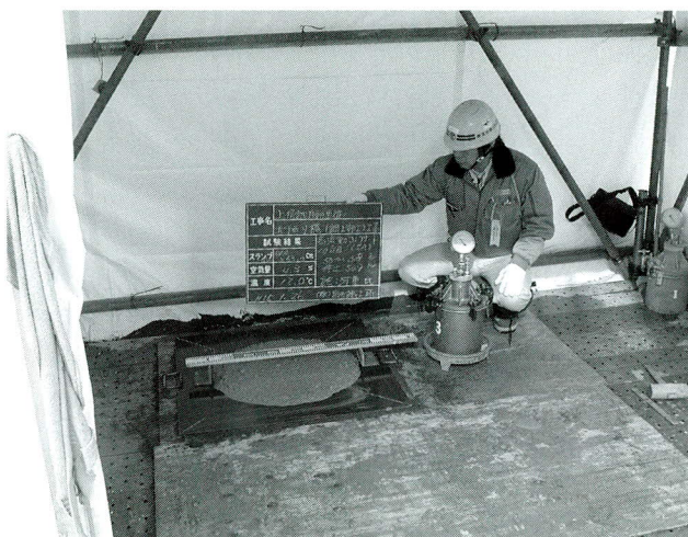
写真-8 コンクリート受入れ検査
