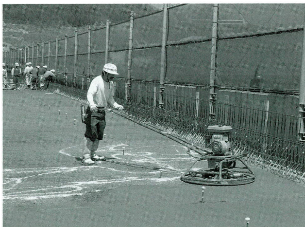
写真-44 床版天端養生材散布 トロウエルによる表面仕上げ
