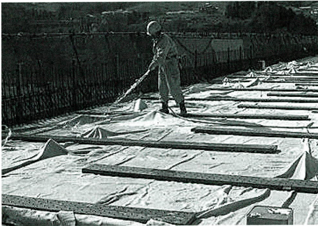
写真-47 養生マット敷設、散水養生
