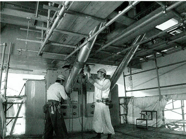
(c) 座屈拘束ブレースの取付け
