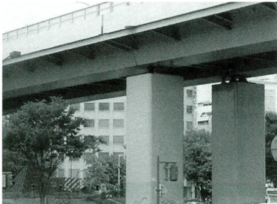
写真-1 独立柱式橋脚を有する橋梁
