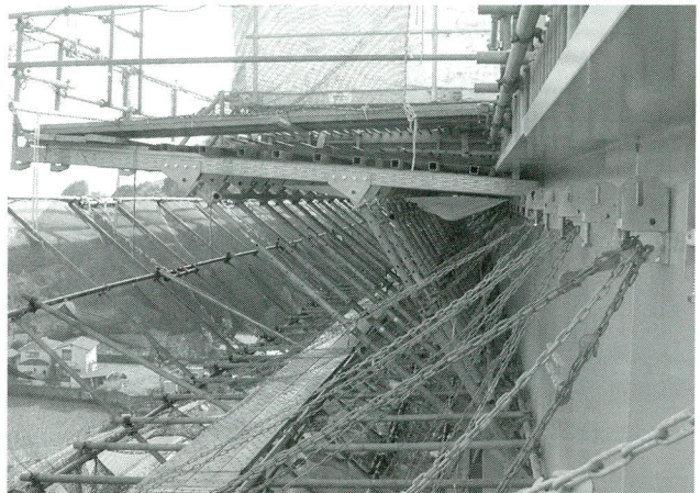
写真-1 支保工設置状況（床版張出部）
