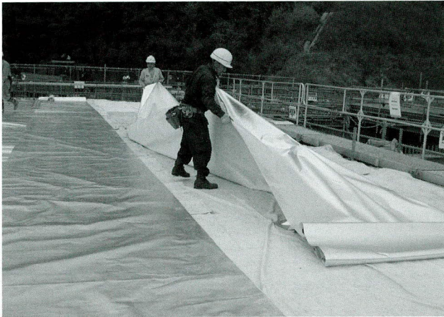
写真-7 遮光シート敷設状況
