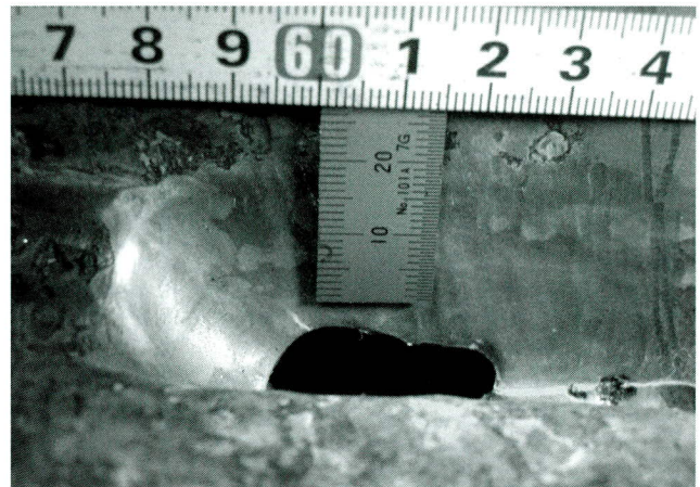
写真-15 カバーPL 端部の除去
