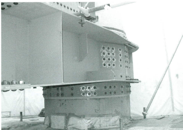
写真-6 円柱部の取付状況
