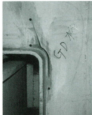
写真-2 主桁桁端切欠き部
