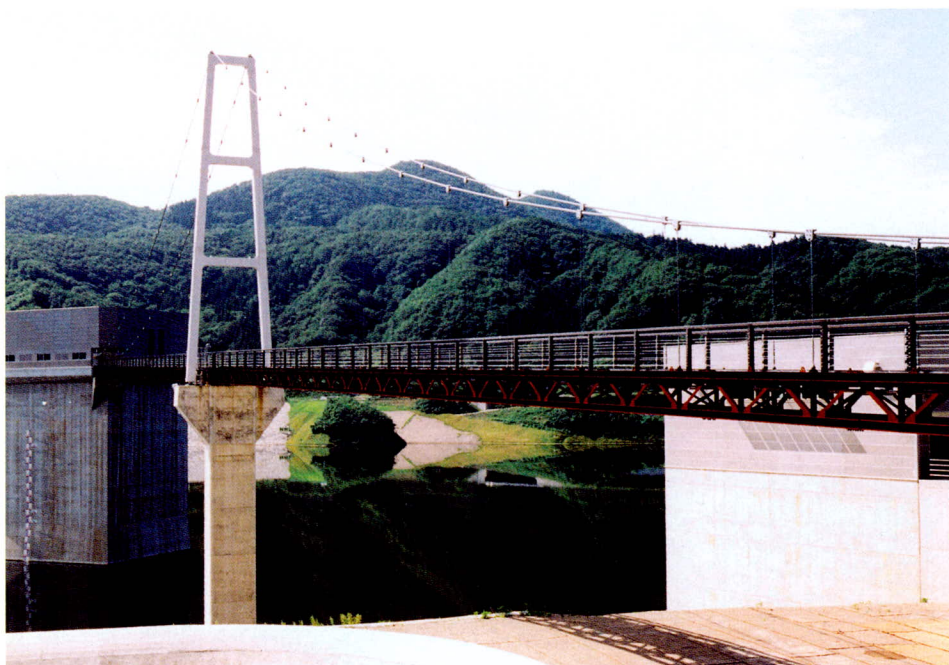
摺上川ダム歩道橋
