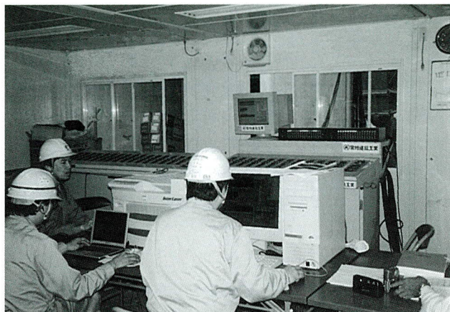
写真-8 集中制御室
