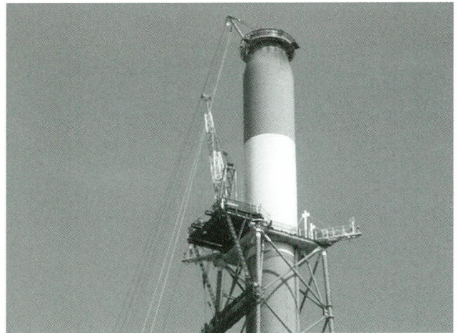
写真-3 煙突頂部
