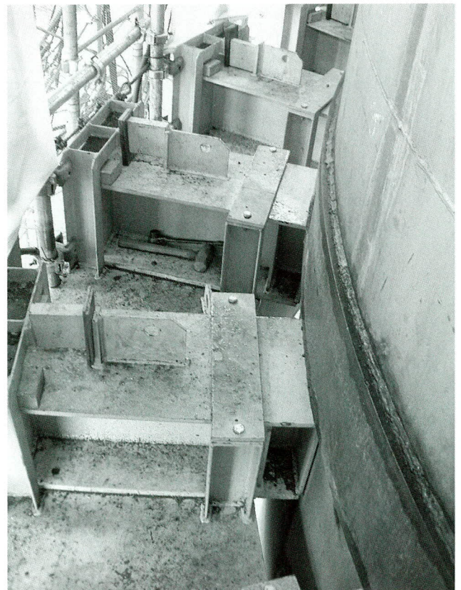
写真-7 筒身吊上部
