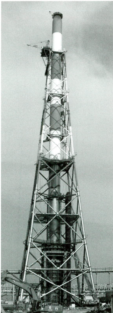
写真-2 2号煙突全景
