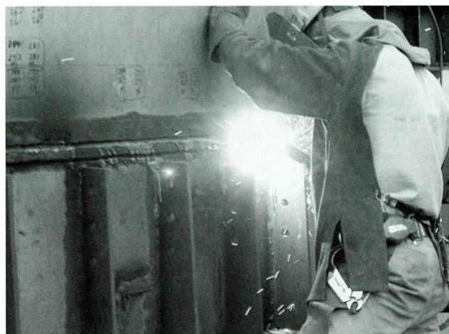
写真-9 筒身切断状況
