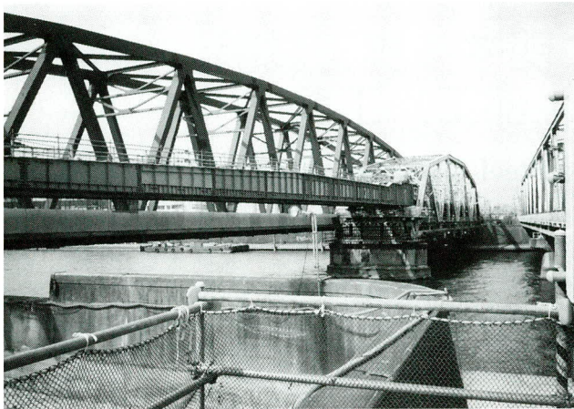
写真－9 架設桁引き戻し状況
