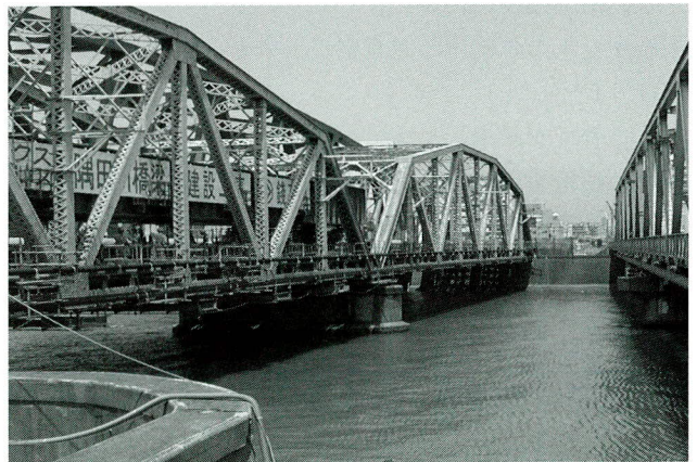
写真-4 架設桁縦移動架設中
