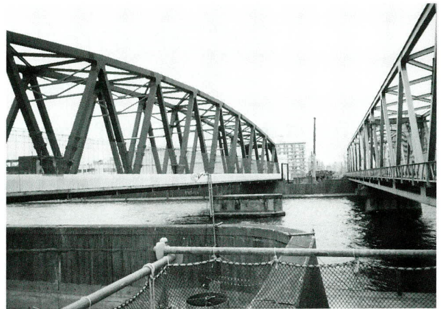
写真－10 撤去完了状況
