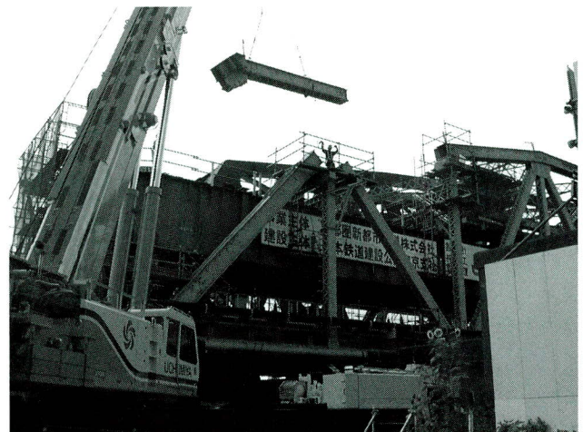
写真-6 最初の上弦材撤去
