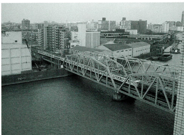
写真-1 従来の常磐線 (今回工事で撤去するトラス)
