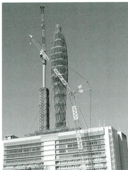
写真－14 建方完了
