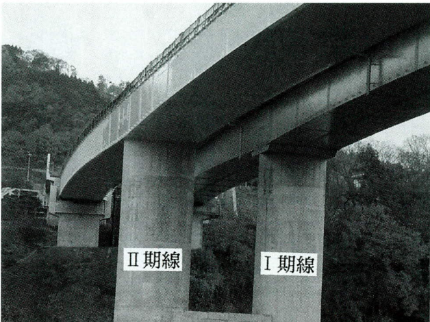
写真-2 II期線柱頭部施工後
