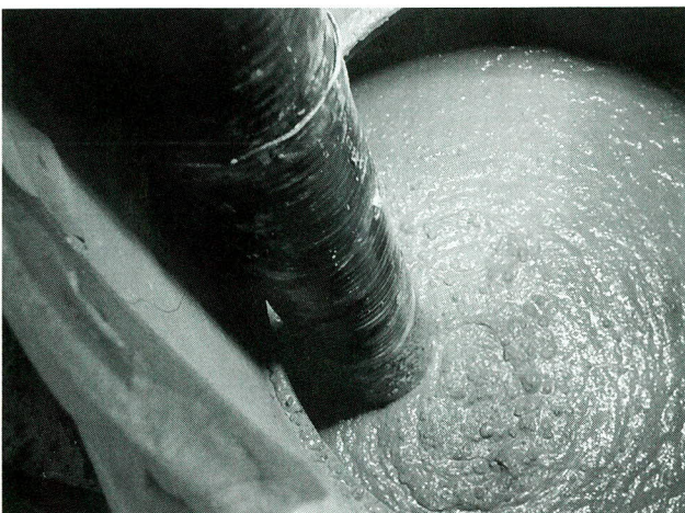
写真-12 柱頭部コンクリート打ち込み状況
