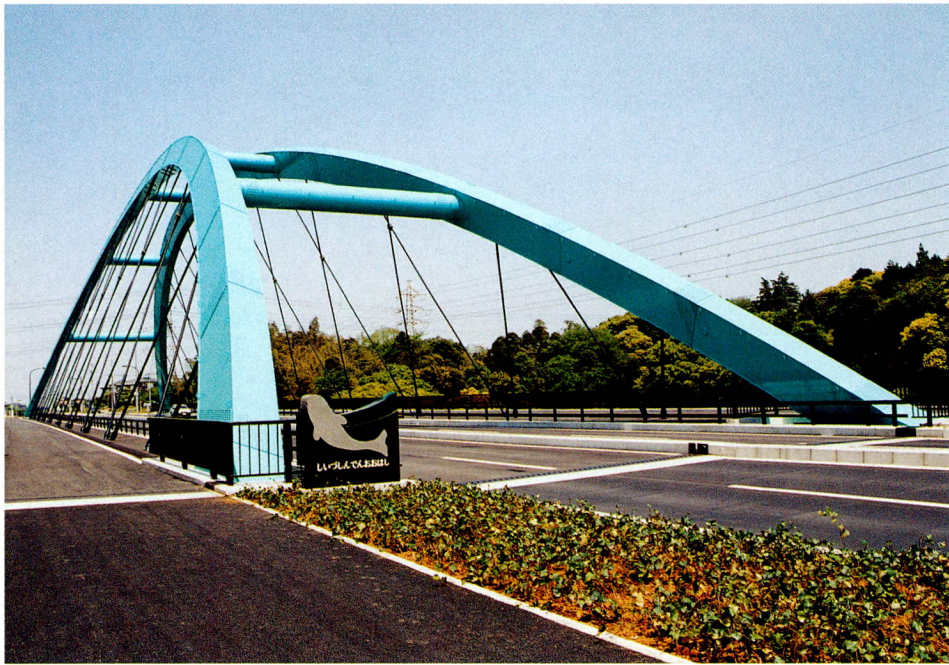
椎津新田大橋（仮称：中台橋梁）
