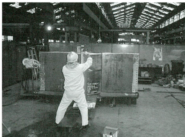
写真-2 柱とウェブを仮置きし、レベル確認
