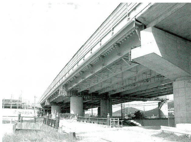
写真-2 底鋼板設置状況（2）
